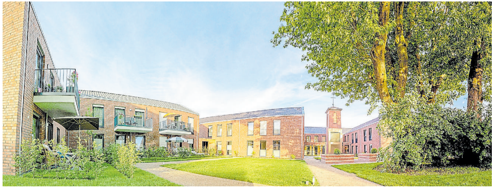
Der neue Magdalenenhof in Lette präsentiert sich nach seiner Fertigstellung und der Gestaltung der Außenanlagen als perfekte Wohnanlage mit zeitgemäßem Gesamtkonzept und beispielhafter Integration in einem parkähnlichen Umfeld.
